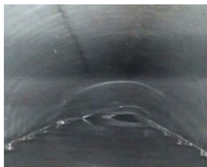
Rys. 2. Deformacja przekroju, widok z oddali (źródło: przedsiębiorstwo wodociągów i kanalizacji)
