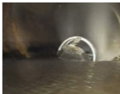
Rys. 2. Czyszczenie kanału (źródło: przedsiębiorstwo wodociągów i kanalizacji) Fig. 2. Stormsewer cleaning (source: municipal company)
