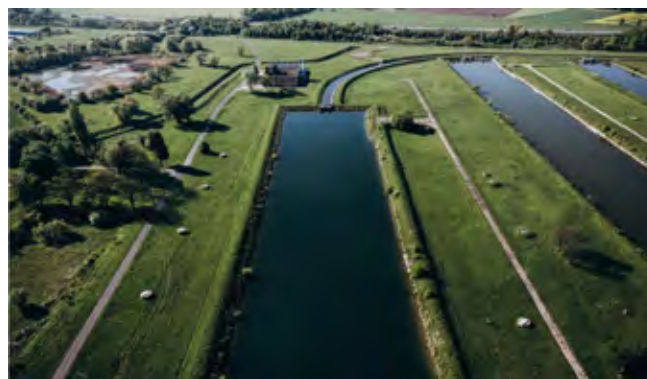
Rys. 4. System rozprowadzania wody do stawów infiltracyjnych
