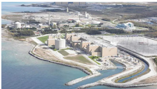
Rys.2. Elektrownia jądrowa Bruce Power Generating Station, Kanada, największa w północnej Ameryce, druga co do wielkości na świecie, 6500 MW mocy, obszar zajmowany 932 ha [6]
