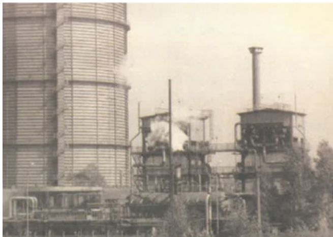
Rys. 4. Widok stacji konwersji gazu w Szopienicach na Śląsku [8] Fig.4. View of the gas conversion plant in Szopienice, Upper Silesia
