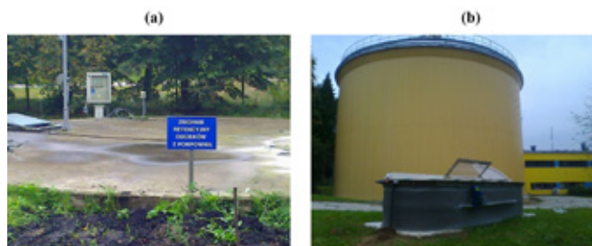
Rys. 3. Zbiornik magazynowy CF-PKOS (a), zamknięta komora fermentacyjna oraz na pierwszym planie wykorzystywany H-FBR (b).
