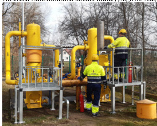
Rys. 7. Prace eksploatacyjne na terenie stacji redukcyjno-pomiarowej zlokalizowanej w Jeleniej Górze.
