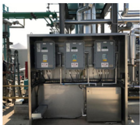
Rys. 1 Analizatory H 2 S, CO 2 i Punktu Rosy Wody na instalacji skraplającej bioLNG
