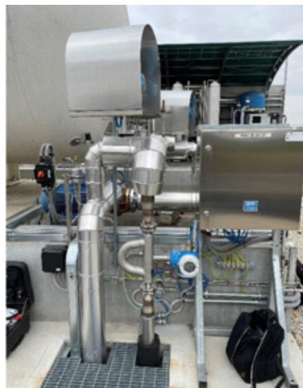
Rys. 1 Urządzenia E+H (Promass Q) na instalacji bioLNG Fig. 1 E+H equipment (Promass Q) on a bioLNG plant
