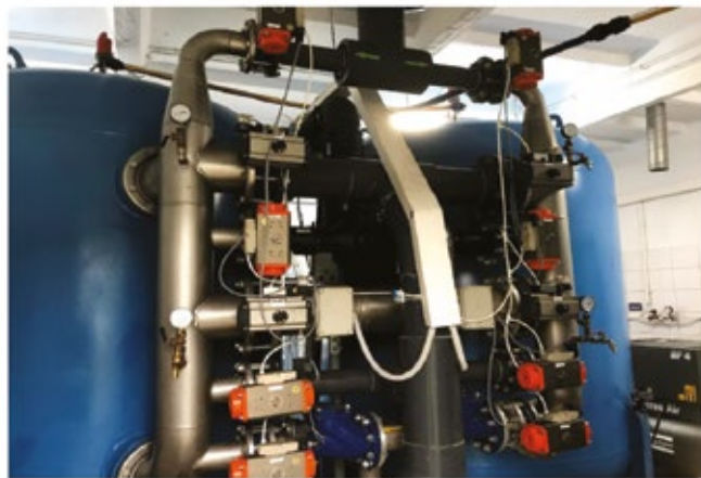
Rys. 1. Filtry ciśnieniowe eksploatowane w ZUW1 Fig. 1. Pressure filters in ZUW1
