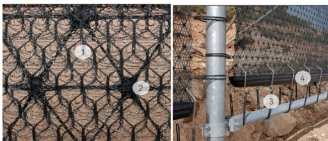
Rys. 14 Kolektory mgły „CloudFisher”. 1 – siatka PEHD, na której skrapla się para wodna, 2 – mocowanie siatki, 3 – gumowe ekspandery redukujące uderzenia wiatru, 4 – elastyczne rynny zbierające i odprowadzające wodę do rurociągów [28]
