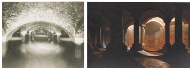
Rys. 6 Po lewej wnętrze filtru powolnego (początek XXw), po prawej wnętrze zbiornika wody czystszej po odnowie (początek XXIw) [1]
