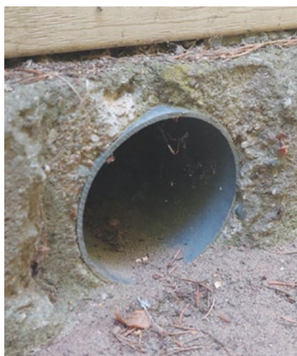
Rys. 11 Rura w piwnicy Fig. 11 Pipe in the basement
