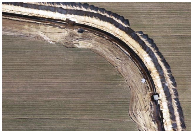
Rys. 3: Fragment wygenerowanej ortofotomapy terenu budowy rurociągu. Fig. 3: Fragment of generated orthophotomap for pipeline construction site.
