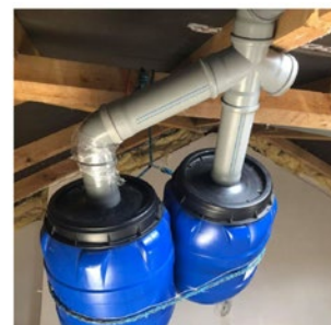
Rys. 3. Układ z dwoma zbiornikami hermetycznymi
