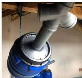
Rys. 2. Układ z jednym zbiornikiem hermetycznym
