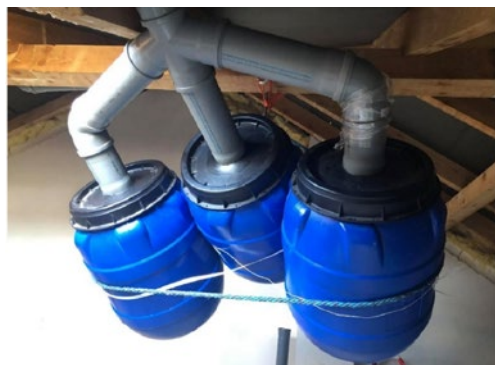
Rys. 1. Zbiorniki hermetyczne zamontowane na obiekcie Fig. 1. Hermetic tanks installed in the building
