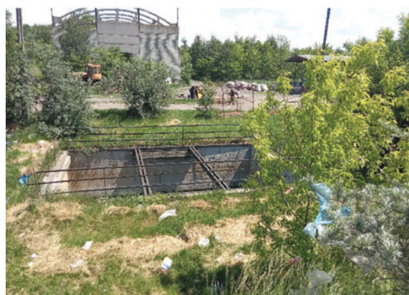
Fig. 1. Filtrate storage tank at the Chervonohrad MSW landfill Rys. 1 Zbiornik odcieku na składowisku MSW Chervonohrad
