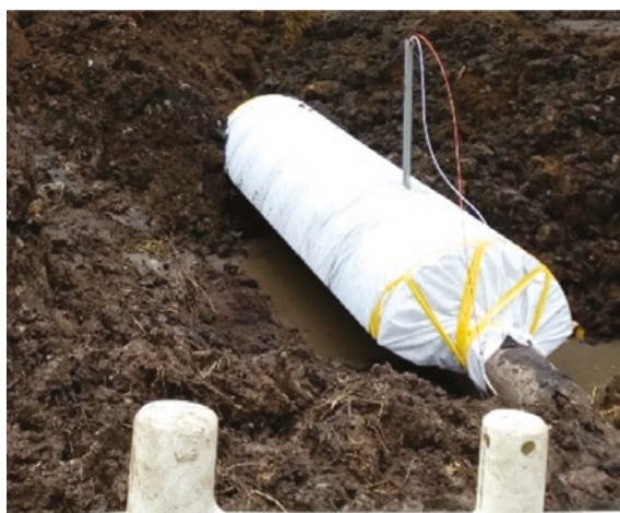
Rys. 6. Widok zabudowanego przetwornika w osłonie zewnętrznej owiniętej rękawem z geowłókniny w warunkach rzeczywistych – stan bezpośrednio przed zakopaniem Fig. 6. The view of the transducer installed in the operating conditions with the outer shelter wrapped around with geotextile – the view directly before being covered
