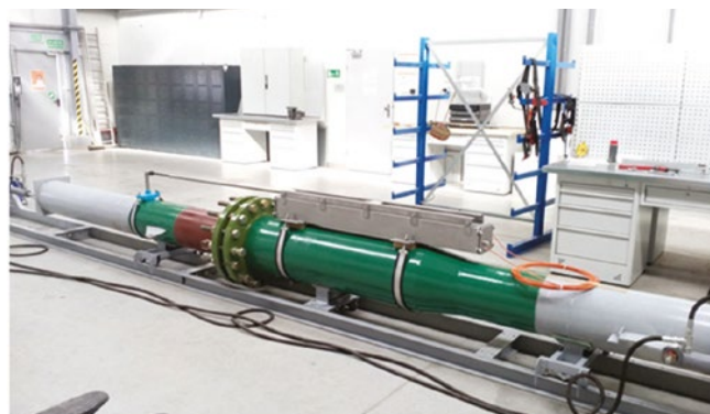
Rys. 7. Widok ogólny stanowiska – przetwornik zabudowany na kompensatorze dławicowym DN300 Fig. 7. The general view of the testing site – transducer mounted on the DN300 gland-type pipeline expansion joint
