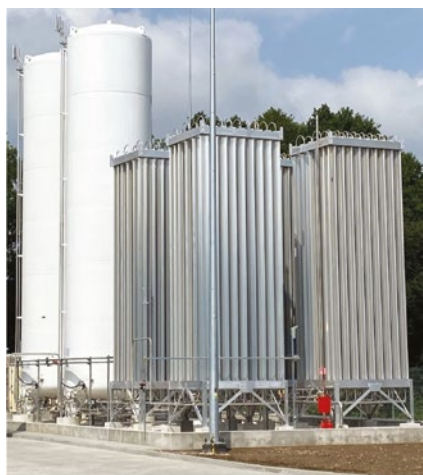
Rys. 1. Przykładowa stacja regazyfikacji LNG (źródło: zdjęcie własne autora.)
