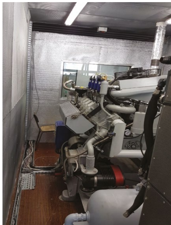
Rys. 7. Układ instalacji w kontenerze z silnikiem i z układem sprężania gazu Fig. 7. System of installation in a container with an engine and a gas compression system
