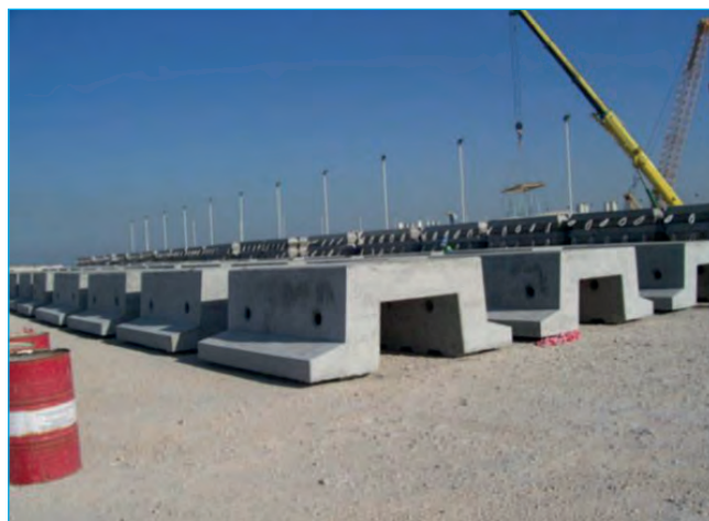
Rys. 10. Prefabrykowane obudowy do ochrony istniejących struktur liniowych [7]
