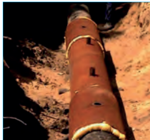
Rys. 4 Renowacja interaktywną wykładziną Compact Pipe ( Materiał firmy Wavin)
