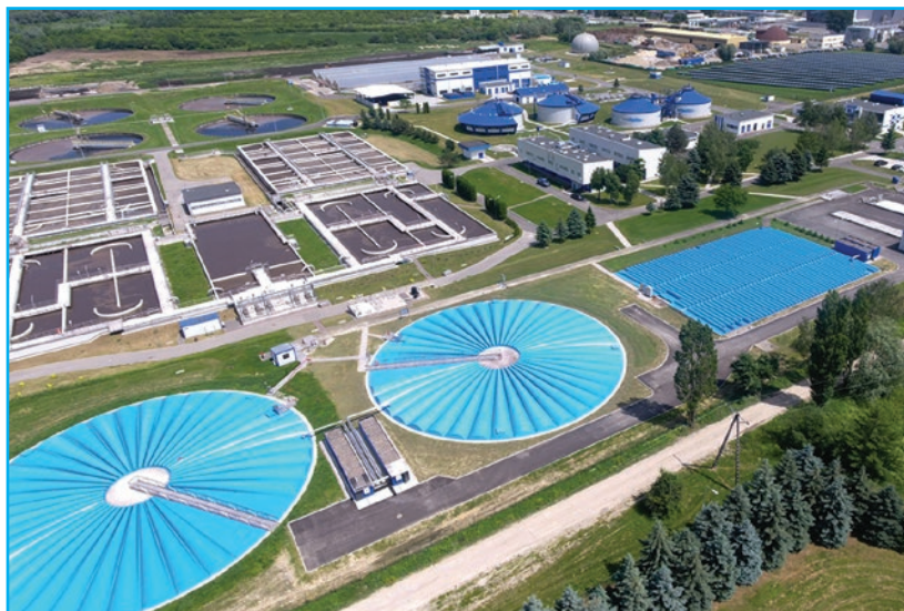
Rys. 5. Widok na zmodernizowaną oczyszczalnię ścieków w Rzeszowie [16]
