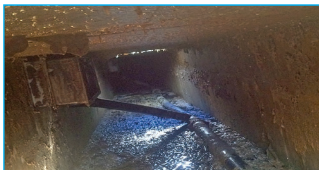
Rys. 2. Rozprowadzenie gazów procesowych do poszczególnych segmentów badanego biofiltra Fig. 2. Distribution of process gases to individual segments of the tested biofilter
