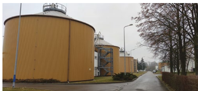
Fot.1 Wydzielone komory fermentacyjne przy Oczyszczalni Ścieków w Siedlcach [5]
