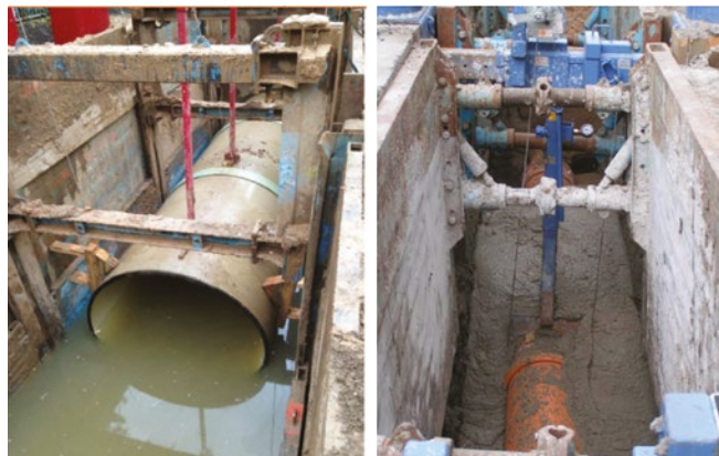
Rys. 5. Układanie rurociągów w wykopie z wypełnieniem w postaci PG w warunkach rzeczywistych Fig. 5. Laying pipes in a trench with the filling material PG in the real conditions
