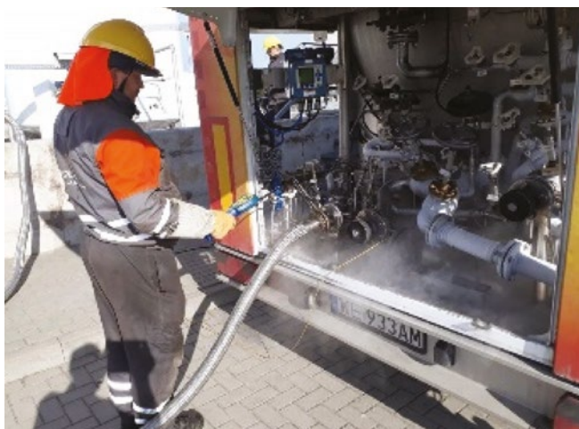
Rys. 15. Kontrola szczelności (źródło: zdjęcie własne) Fig. 15. Leak detection (source: own picture)
