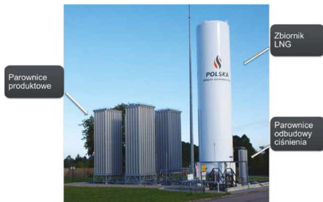
Rys. 1. Podstawowe elementy instalacji LNG (źródło: opracowanie własne) Fig. 1. Basic elements of LNG regasification station (source: own study)
