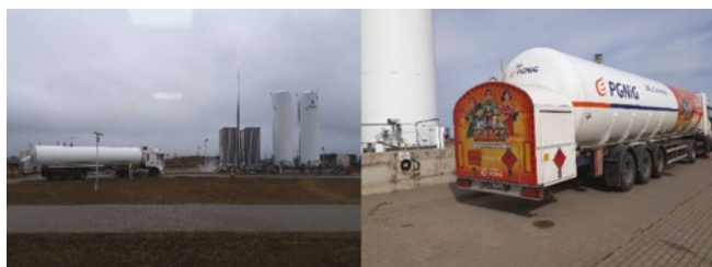
Rys. 9. Autocysterna na stanowisku rozładowania (źródło: zdjęcia własne) Fig. 9. LNG road tanker at the unloading point (source: own pictures)
