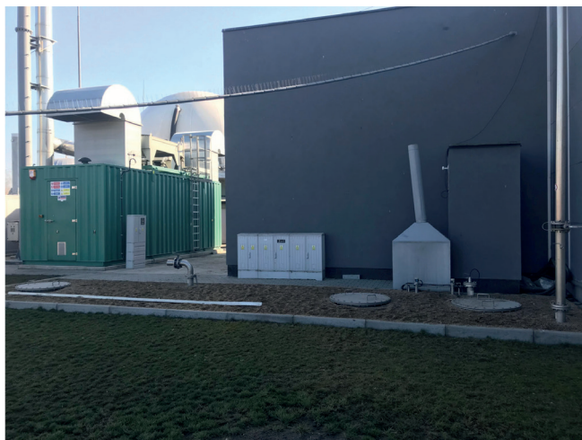
Rys. 3. Instalacja antyodorowa na terenie jednej z polskich biogazowni (fotografia własna).
