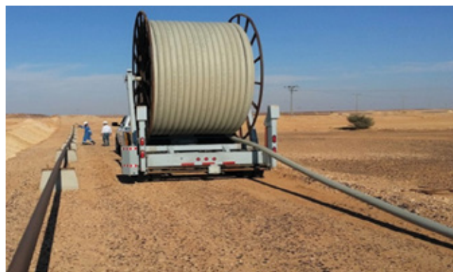
Rys. 2. Montaż rurociągu kompozytowego RTP ( źródło: http://fartrouven.pt/en/articles/art_2.html )
