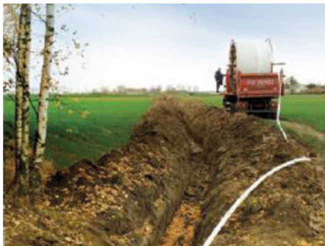
Rys.4. Montaż rur RTP w wykopie otwartym. (źródło: https://cgh.com.pl/cgh-rtp-pipe/instalacja-thermoflex )
