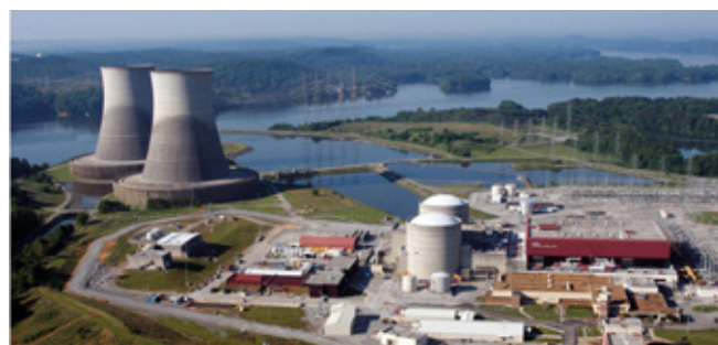
Rys.3. Dwa reaktory jądrowe w elektrowni TVA Watts Bar w hrabstwie Rhea w stanie Tennessee, USA [6]
